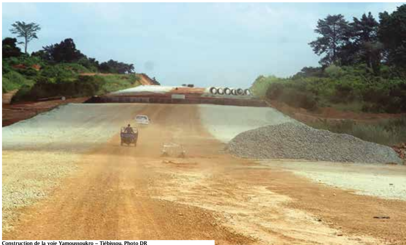
Construction de la voie Yamoussoukro – Tiébissou. Photo DR
