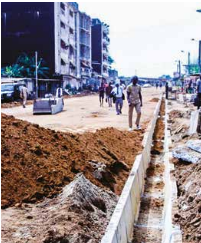
Yopougon Maroc et Ananeraie : Voiries et assainissement dans la commune. Photo DR
