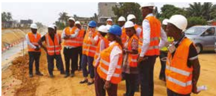
Visite du chantier du Drain de Yopougon par la directrice des opérations et une vice-présidente de la Banque mondiale en février 2020
