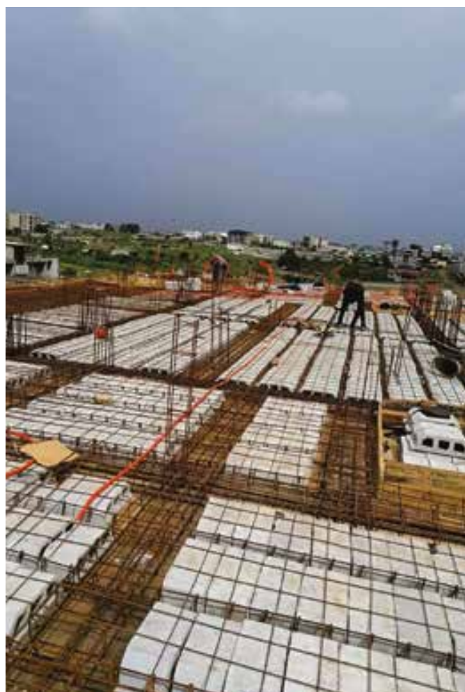
Un chantier de Kiki déco
