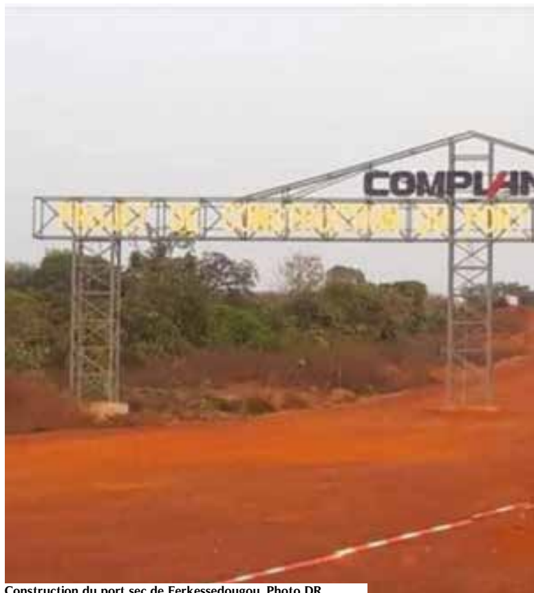
Construction du port sec de Ferkessedougou. Photo DR
