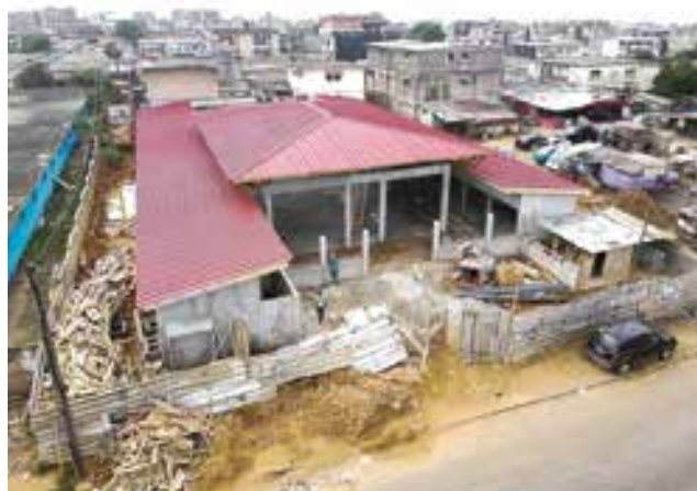
Yopougon Ananeraie-Coopec : Chantier du Marché des tresses et coiffures également dédié à l'horlogerie et à la lunetterie. Photo DR
