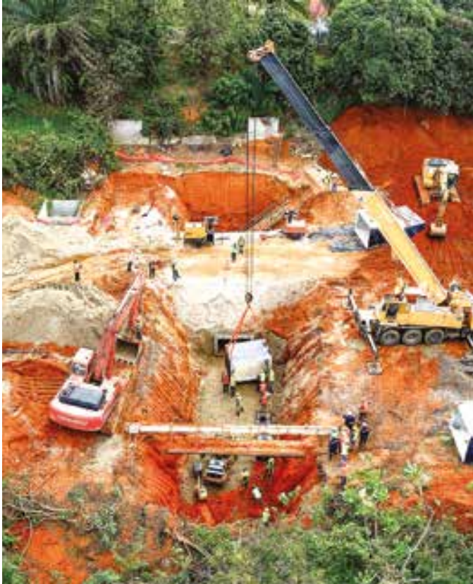
Construction de la voie du Train Urbain d'Abidjan. Photo DR
