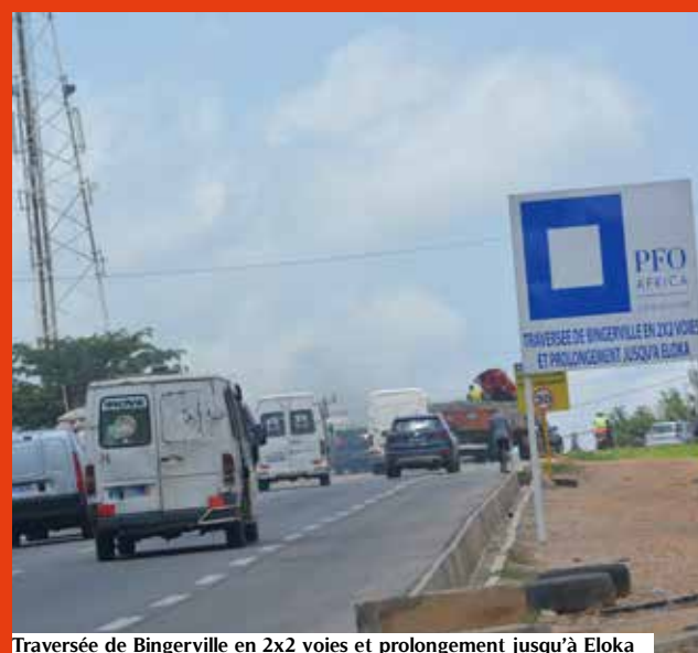
Traversée de Bingerville en 2x2 voies et prolongement jusqu'à Eloka
