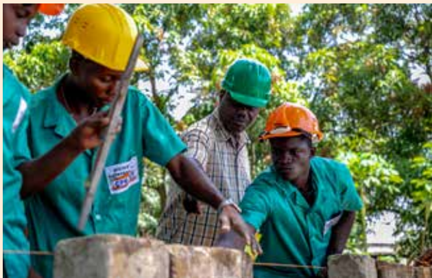
La topographie réalisée sous la conduite de son collègue Kablan S., le professeur de maçonnerie Otchoumou Vangah Léonce prend la relève avec les élèves pour l'exercice d'implantation suivi de la construction du bâtiment.
