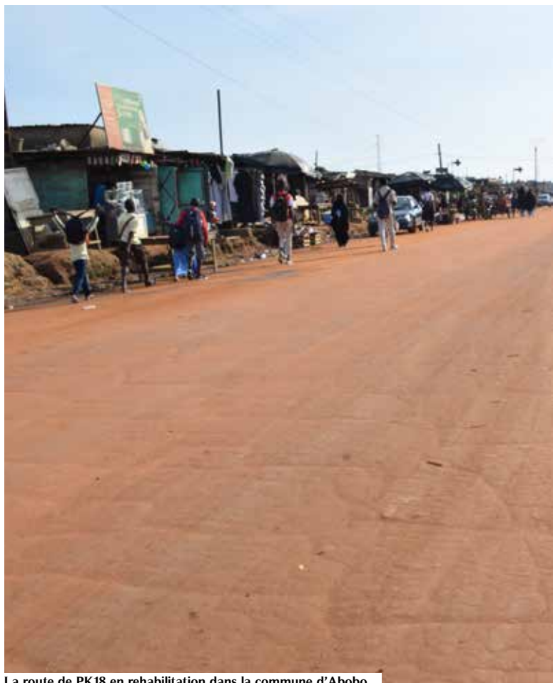
La route de PK18 en réhabilitation dans la commune d'Abobo
