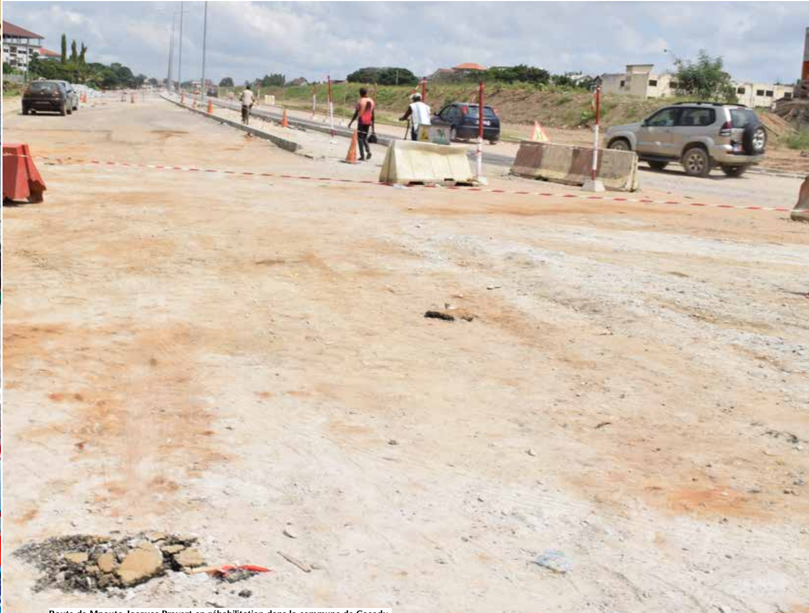
Route de Mpouto Jacques Prevert en réhabilitation dans la commune de Cocody
