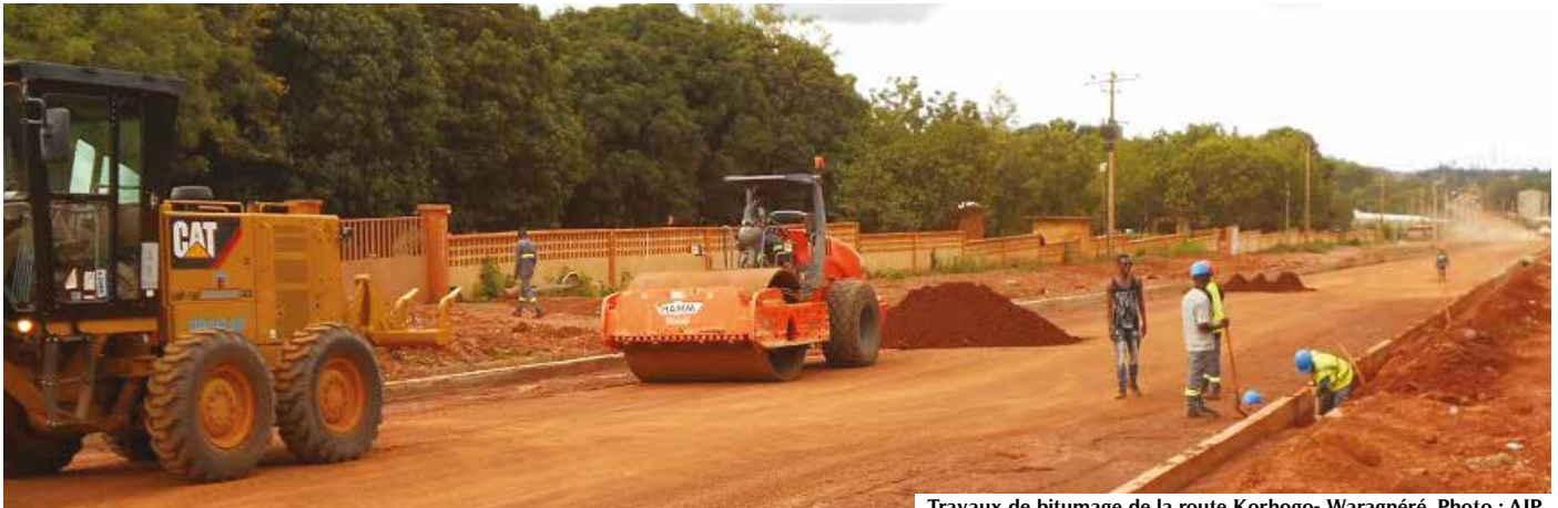
Travaux de bitumage de la route Korhogo- Waragnéré. Photo : AIP
