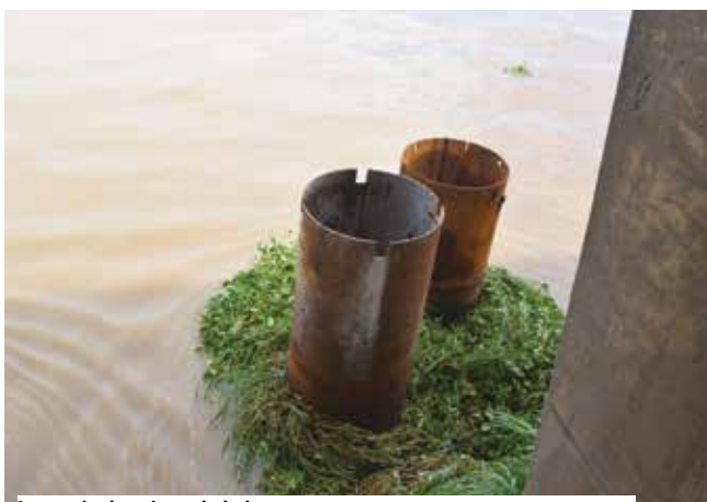
La sortie des pieux de la lagune
