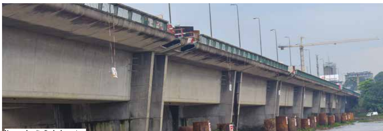
Une vue longitudinale du pont
