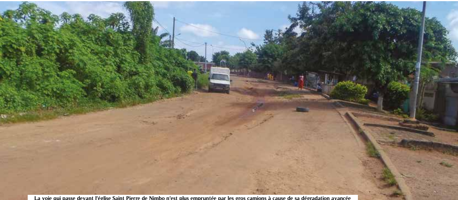
La voie qui passe devant l'église Saint Pierre de Nimbo n'est plus empruntée par les gros camions à cause de sa dégradation avancée
