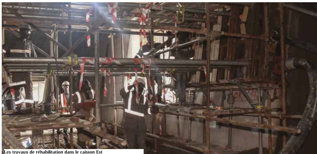
Les travaux de réhabilitation dans le caisson Est
