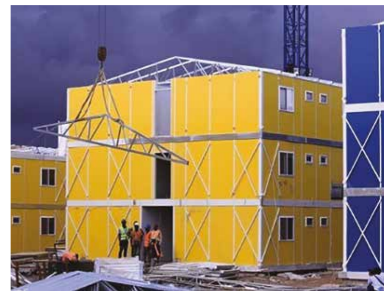
Maison préfabriquée à l'Institut National de la Jeunesse et des Sports
