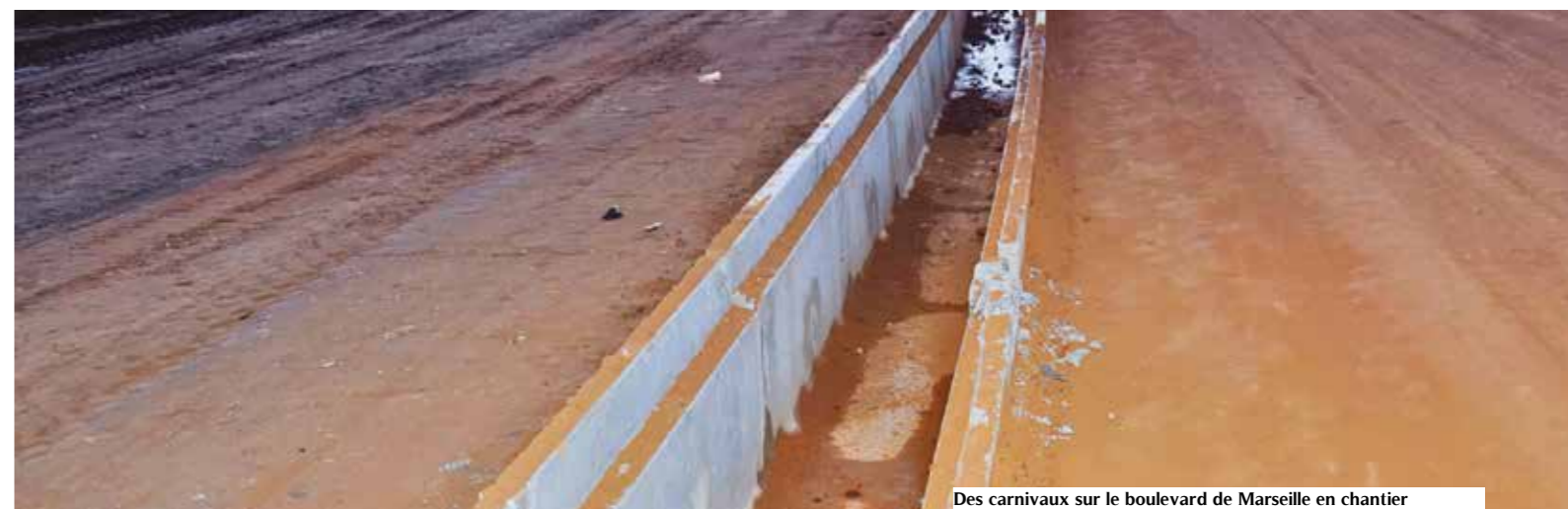
Des caniveaux sur le boulevard de Marseille en chantier
