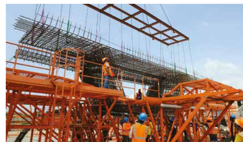
Techniciens et ouvriers lors de la construction du 3 e pont d'Abidjan. Photos DR
